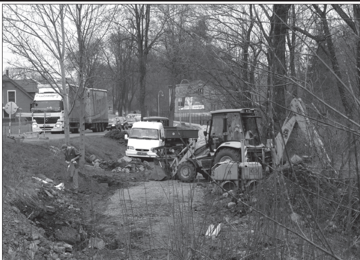
Přemostění Kopřivničky v Příboře při výjezdu směrem na Lubinu si do konce měsíce května vyžádá omezení dopravy v jednom směru. Doprava je řízena světelnými semaforů. FOTO: ILONA MAZALOVÁ
