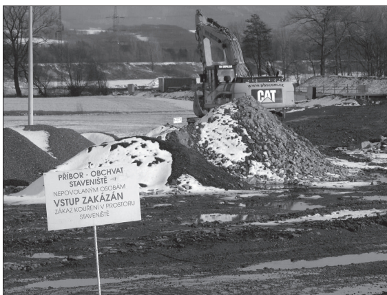
Budování obchvatu Příbora v oblasti Pasek dopravu zatím příliš neomezovalo. S jarem se ale dají na silnicích očekávat komplikace.
