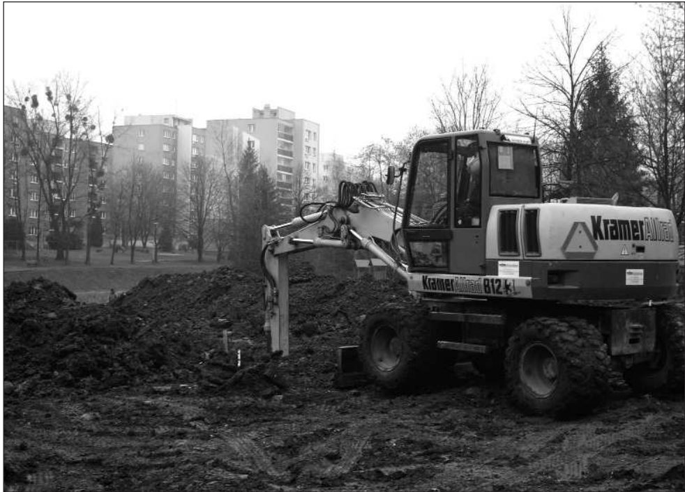
Stavba nového dětského dopravního hřiště se rozjela. Minulý týden těžká technika začala budovat kanalizace.
