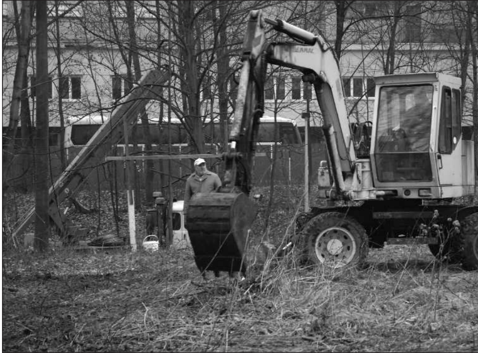
Těžká technika začala minulou středu s hloubením základů pro stavbu budoucího skautského centra Vanaivan.
