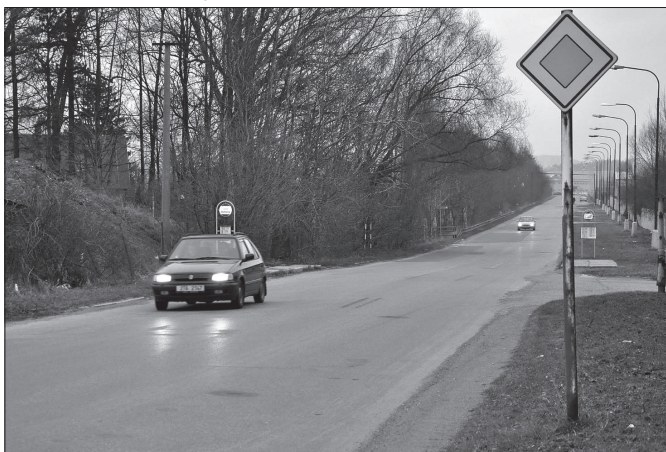
Rekonstrukce ulice Panské i její výkup bude jistě už záležitostí příštího roku. To, kdy a v jakém rozsahu bude rekonstrukce realizována, záleží na rozhodnutí kraje.
