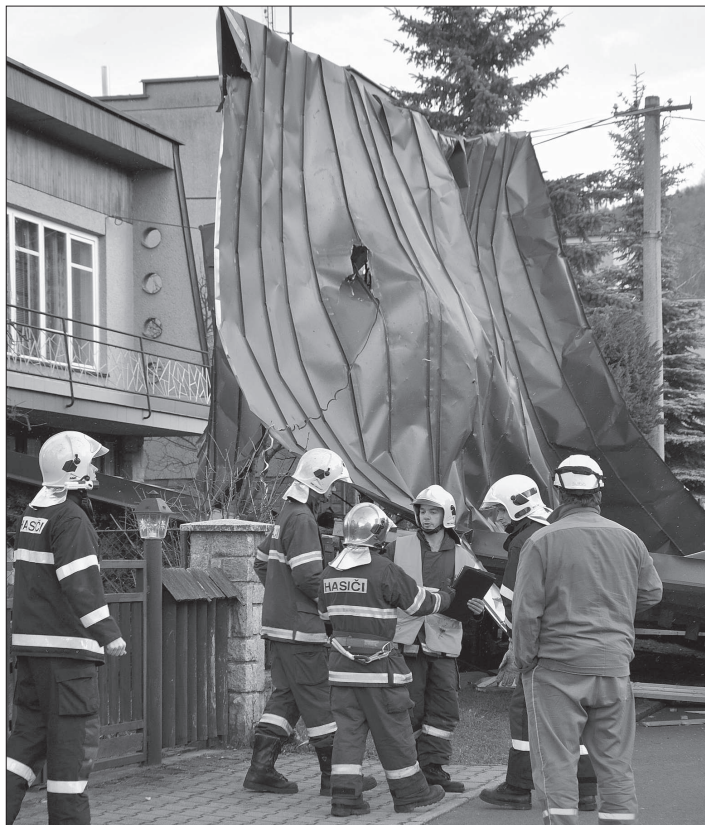
Jako kus hadru se střecha jednoho z domů na ulici Havlíčkově pověsila na elektrické vedení. Orkán v Kopřivnici napáchal i řadu dalších škod. FOTO: DAVID MACHÁČEK
