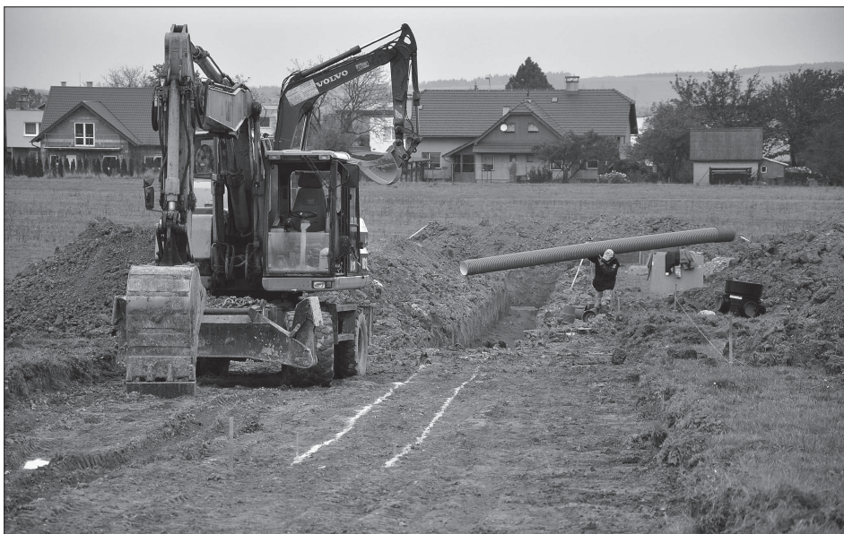
Zatím je to jen stavební výkop, ale už za několik týdnů se promění v novou ulici. Na jaře by pak kolem ní měly začít vyrůstat rodinné domy.
