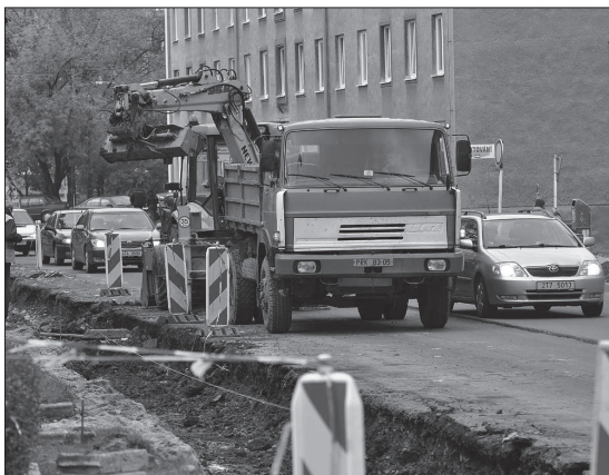
Chodci i motoristé budou muset komplikace vznikající při stavbě nových chodníků snášet ještě víc jak měsíc.
