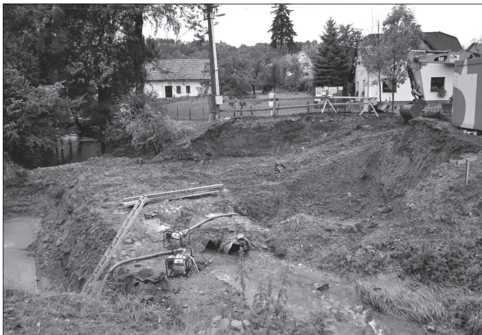
V místech původního silničního mostu v Závašicích nyní zeje hluboká stavební jáma. Nový a bezpečnější most by zde měl stát začátkem příštího roku.
