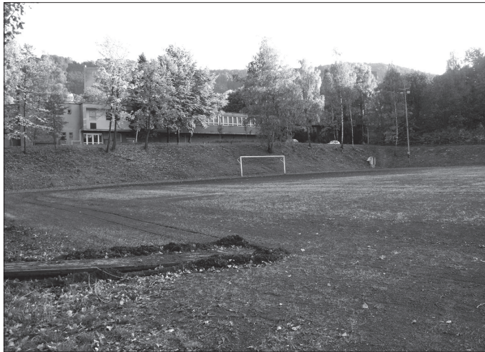
V tomto týdnu začnou práce na kompletním přebudování škvárového fotbalového hřiště v travnatou tréninkovou plochu zdejších fotbalistů.
