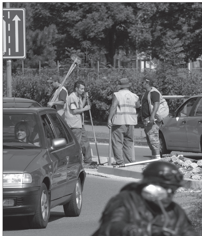
Ještě tento týden by měly skončit stavební práce u okolí kruhového objezdu. Úpravy chodníků ve městě budou pokračovat až do 22. října.
