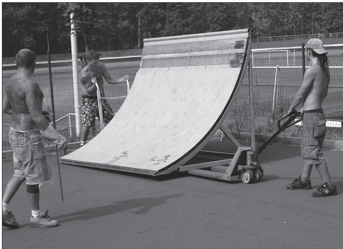
Pracovníci společnosti Mystic Construction instalují jednu ze sedmi nových překážek kopřivnického skateparku. Ten se zájemcům otevře znovu příští týden. FOTO: DAVID MACHÁČEK
