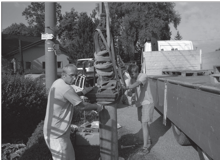
Restaurátoři demontují pískovcový mariánský sloup v Mniší, památka nyní projde čištěním a impregnací. Na své místo se vrátí pravděpodobně v říjnu.
