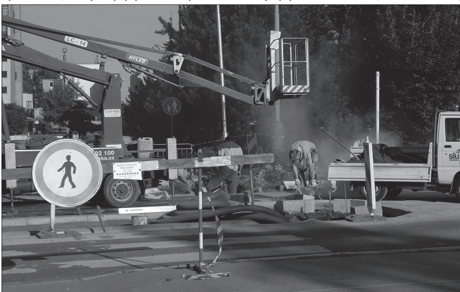
V rámci projektu Bezbariérové město je upravován také frekvencovaný přechod před radnicí. Jeho přestavba by měla být dokončena do termínu kopřivnické pouti, nejpozději do konce prázdnin.
