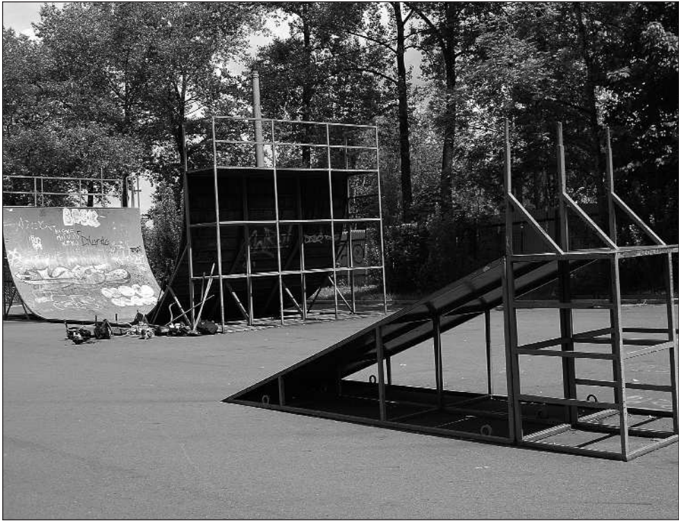
Největší překážka ve skateparku takzvaná U-rampa neodpovídá předpisům a musí být odstraněna. Celý areál bude do půlky prázdnin mimo provoz.
