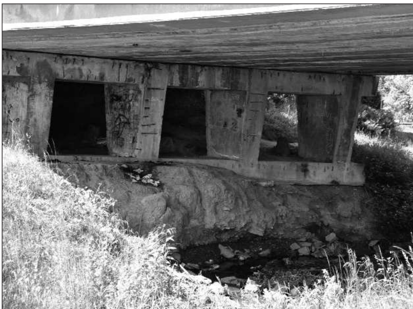
Během pár dnů začnou pracovníci ostravské firmy Makos zpevňovat podemletý pilíř mostu na Erbenově ulici. FOTO: DAVID MACHÁČEK
