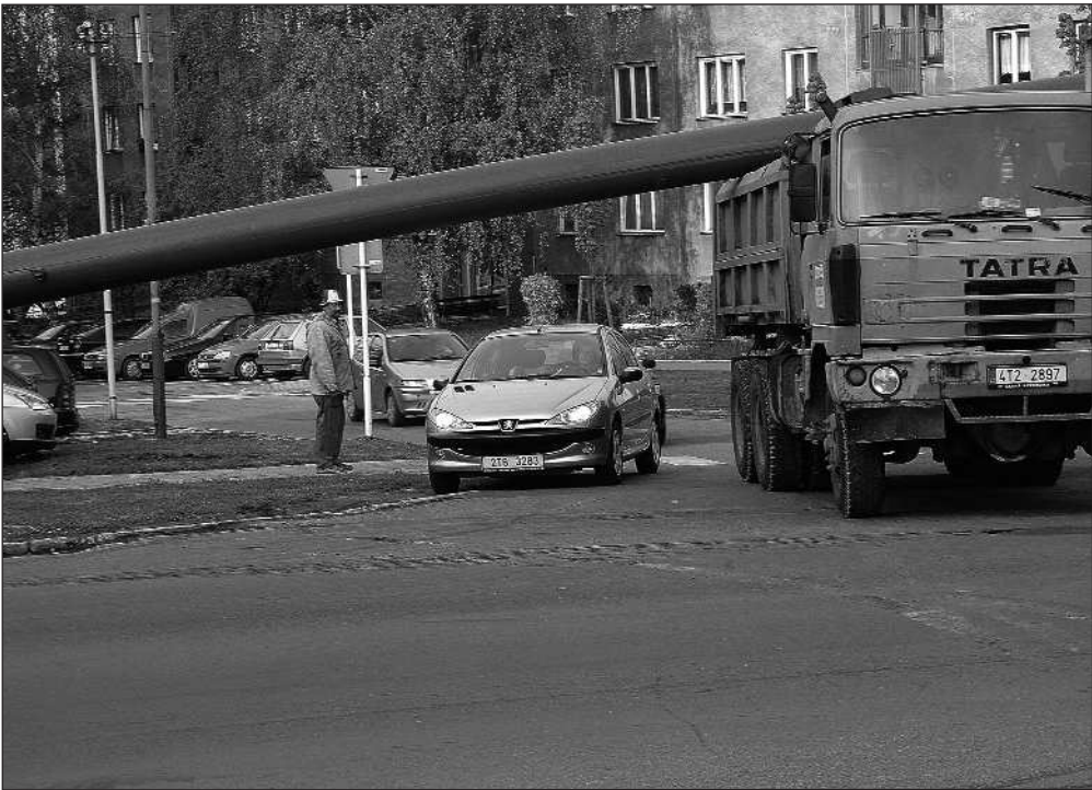
Při rekonstrukci vodovodního potrubí na ulici Obránců míru docházelo i ke kuriózním situacím, kdy auta musela podjíždět instalované potrubí. FOTO: DAVID MACHÁČEK
