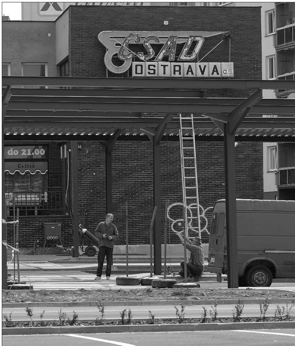
Rekonstrukce autobusového nádraží měla být hotova vloni na podzim, ale stavební práce ještě ani zdaleka neskončily.
