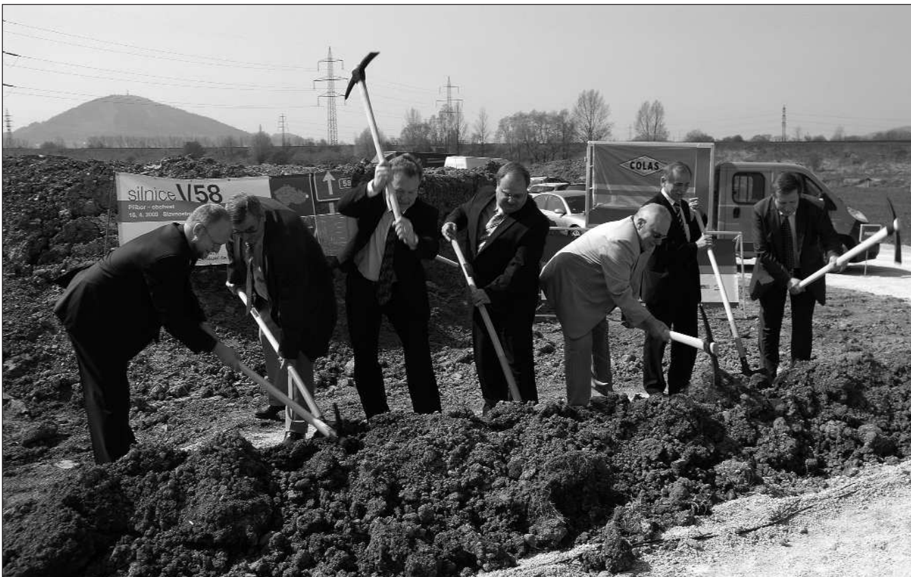
Zástupci kraje, měst, investora i zhotovitele přesně před týdnem zahájili stavbu obchvatu Příbora. Stavbu, která má trvat do září 2011, mohou zkomplikovat snahy majitelů některých pozemků o jejich navrácení. FOTO: DAVID MACHÁČEK
