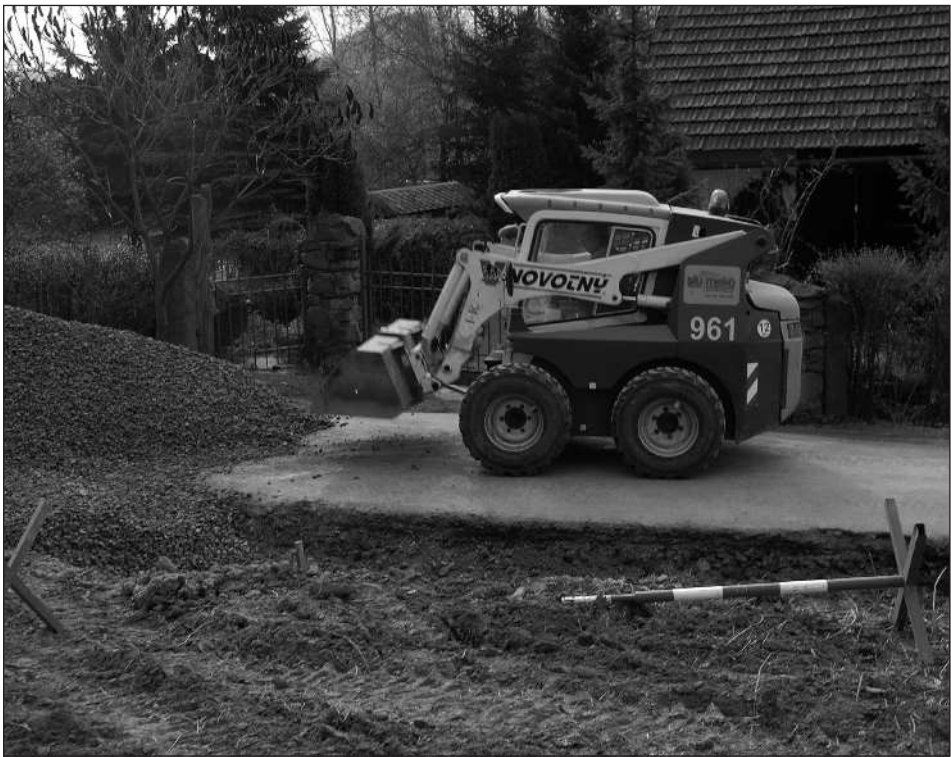
Stavba dalších výhyben na silnici spojující Mniší s Měrkovicemi si vyžádala asi měsíční omezení provozu.
