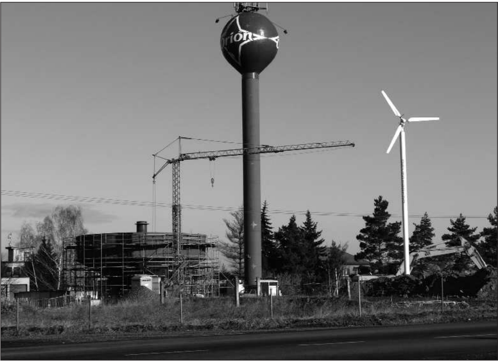
Vodojem ve tvaru létajícího talíře určený pro letiště a průmyslovou zónu se buduje na katastru Petřvaldu u silnice I/58 z Příbora na Ostravu. Jedná se v pořadí o čtvrtý vodojem v obci. FOTO: I. MAZALOVÁ
