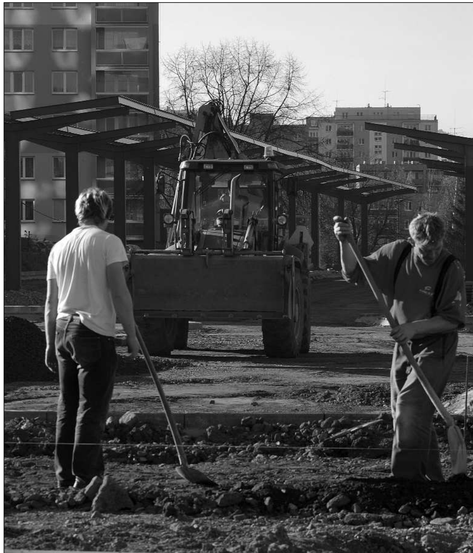
Po budoucím autobusovém nádraží se zatím místo autobusů prohání jen stavební technika. Zprovoznění nádraží se oproti plánu odkládá o půldruhého měsíce.
