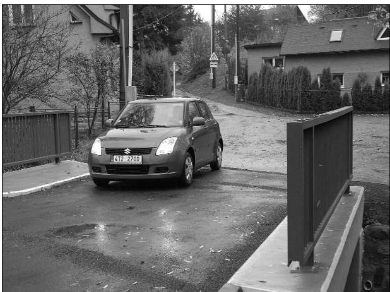
Rekonstruovaný most ve Větrkovicích je už znovu v provozu, lidé si tak ušetří kilometry naježděné po objízdných trasách. FOTO: DAVID MACHÁČEK
