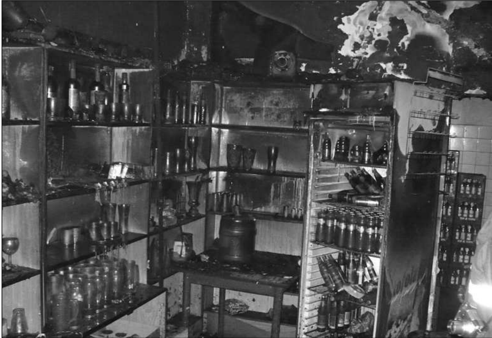
Prostory baru v restauraci Kavárna zničené ohněm a kouřem, hasiči odhadli škodu na 200 tisíc korun, plameny vznikly asi závadou na elektroinstalaci nebo od cigarety.
