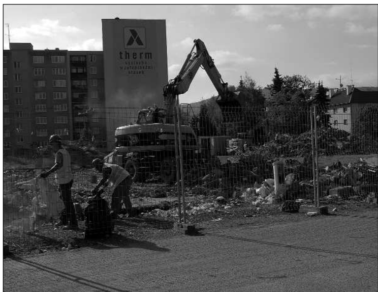
Na prostranství u výjezdu na Závěšici zatím pracují demoliční čety, už brzy je ale vystřídají stavební dělníci. FOTO: DAVID MACHÁČEK
