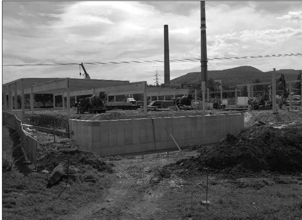
Stavba nového obchodního domu Tesco je v plném proudu a roste přímo před očima. Není divu, investor plánuje otevřít ještě před Vánoci.
