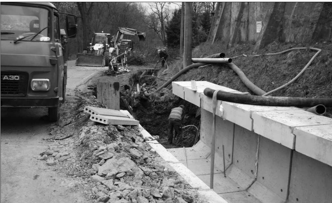
Práce na rekonstrukci mlýnského náhonu a vybudování chodníku na komunikaci I/58 kolem kostela si ve Vlčovicích vyžádaly i dopravní omezení, které potrvá až do 23. května.
