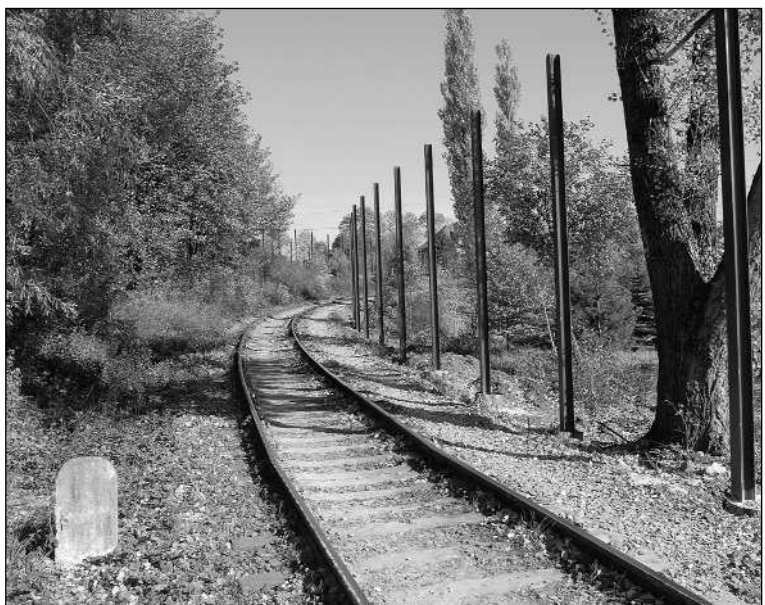
Piloty, ve kterých budou ukotveny protihlukové bariéry u vlečky na štramberské Kozině, stojí už dnes. FOTO: DAVID MACHÁČEK
