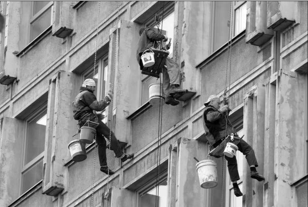
Dělníci na laně odstraňují z pláště budovy nové radnice kusy zvětralého betonu, práce na tomto provizorním řešení by měly při dobrém počasí skončit tento týden.
