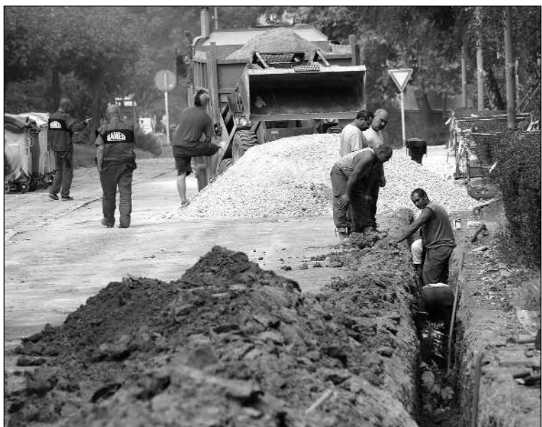
Rekonstrukce vodovodního potrubí na ulici Karla Čapka bude ještě nějakou dobu komplikovat pohyb po chodnicích i silnici. FOTO: D. MACHÁČEK
