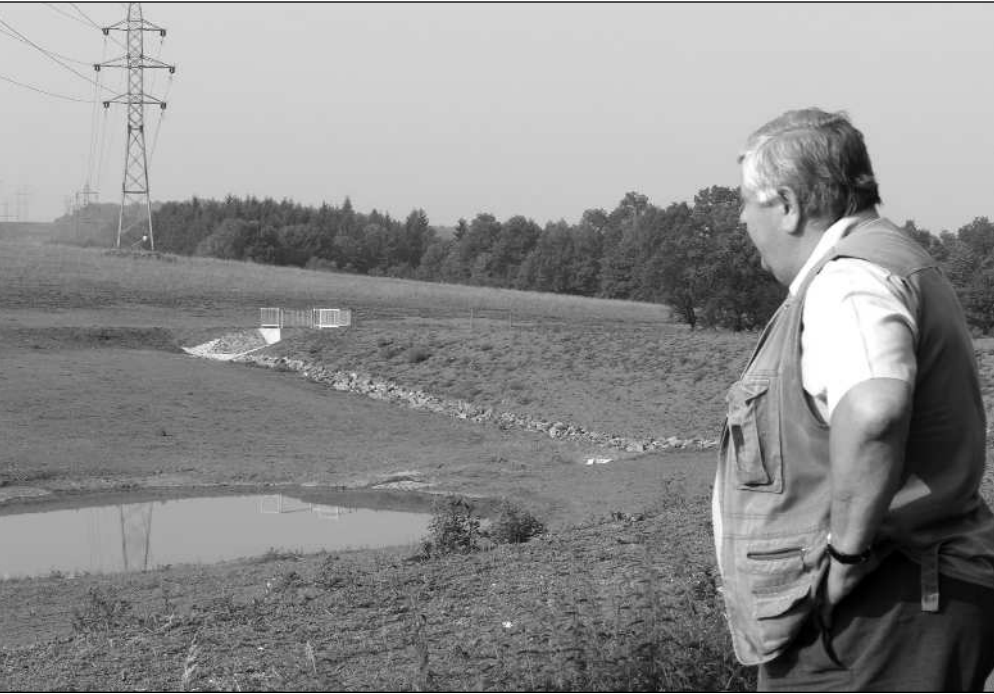
Protipovodňový poldr ochrání část Kateřiníc před častými záplavami. „Na podzim ještě provedeme výsadbu keřů,“ dodal starosta Vladimír Londín.
