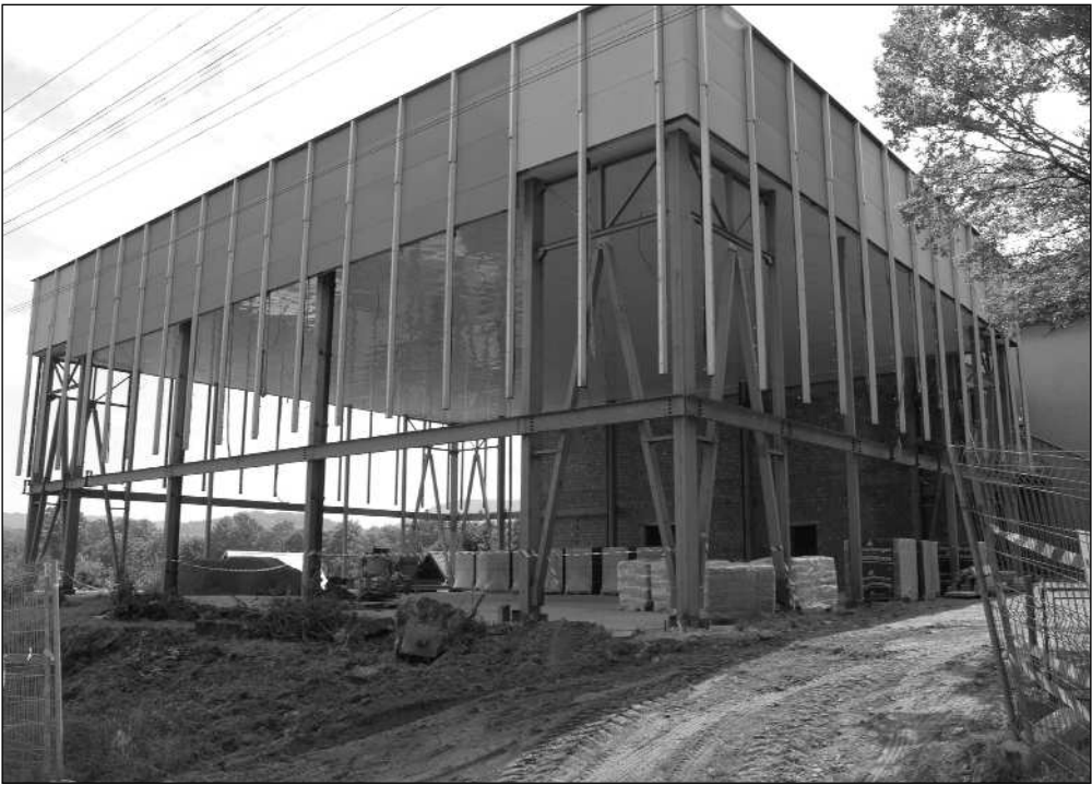
Pracovníci firmy Tchas museli nejdříve demontovat původní skelet tělocvičny v Lubině, aby mohli začít se stavebními pracemi. Ty mají být dokončeny do konce října.
