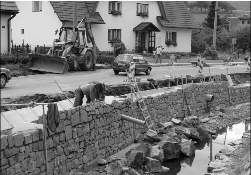
Závišičti občané se dočkají chodníků okolo průtahu obcí. V rámci jeho budování je opravováno také zpevnění koryta říčky Sedlnice.
