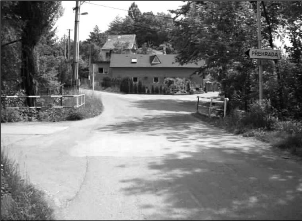
Z důvodu snížení tonáže mostu v Lubině pod přehradou vznikly místnímu družstvu potíže. Na pole do Mniší musí se svými stroji jezdit přes celou Lubinu.
