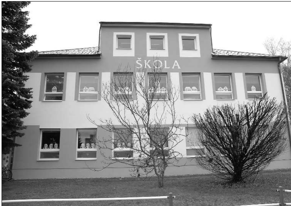
Základní škola v Závišicích se po rekonstrukci může pochlubit interiérovým nadstandardem i novou zateplenou fasádou.
