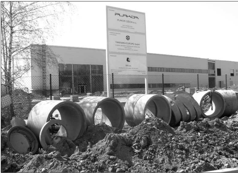
Průmyslová zóna v Mošnově připomíná jedno velké staveniště. Přesto v hale korejské firmy Plakor bude během měsíce května spuštěn zkušební provoz. FOTO: ILONA HOFFMANNOVÁ
