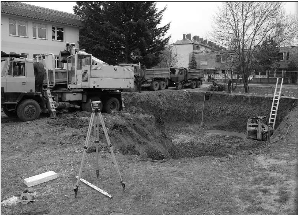
Výkopové práce na základech budoucího hotelu se rozběhly minulý týden. Za necelý rok už bude na ulici Kpt. Jaroše stát nová budova s kapacitou 44 lůžek.
