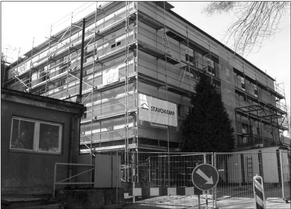
V nadstavbě nad vstupem do tělocvičny ve Štamberku vzniklo nové zázemí pro sport. Kromě další menší tělocvičny zde bude lezecká stěna i zázemí pro judisty.
