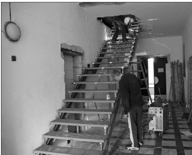
Schody budované v nejvyšším patře Katolického domu povedou k nově budovanému multifunkčnímu sálu v podkroví. FOTO: DAVID MACHÁČEK
