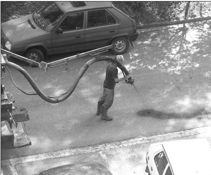
Opravy výtluků byly prováděny buď teplou obalovanou směsí, nebo tryskovou metodou.
