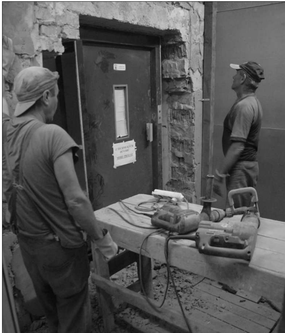
V kulturním domě začaly práce na modernizaci a především prodloužení výtahu, který má zajistit pohodlný přístup imobilním lidem do městské knihovny. FOTO: DAVID MACHÁČEK
