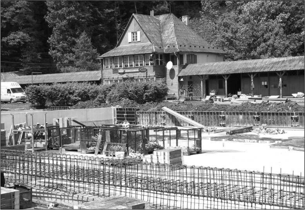
Na libotínském koupališti to zatím rozhodně nevypadá na brzký začátek letní sezony. Zatím se budoucím bazénem prohánějí místo plavců betonáři.
