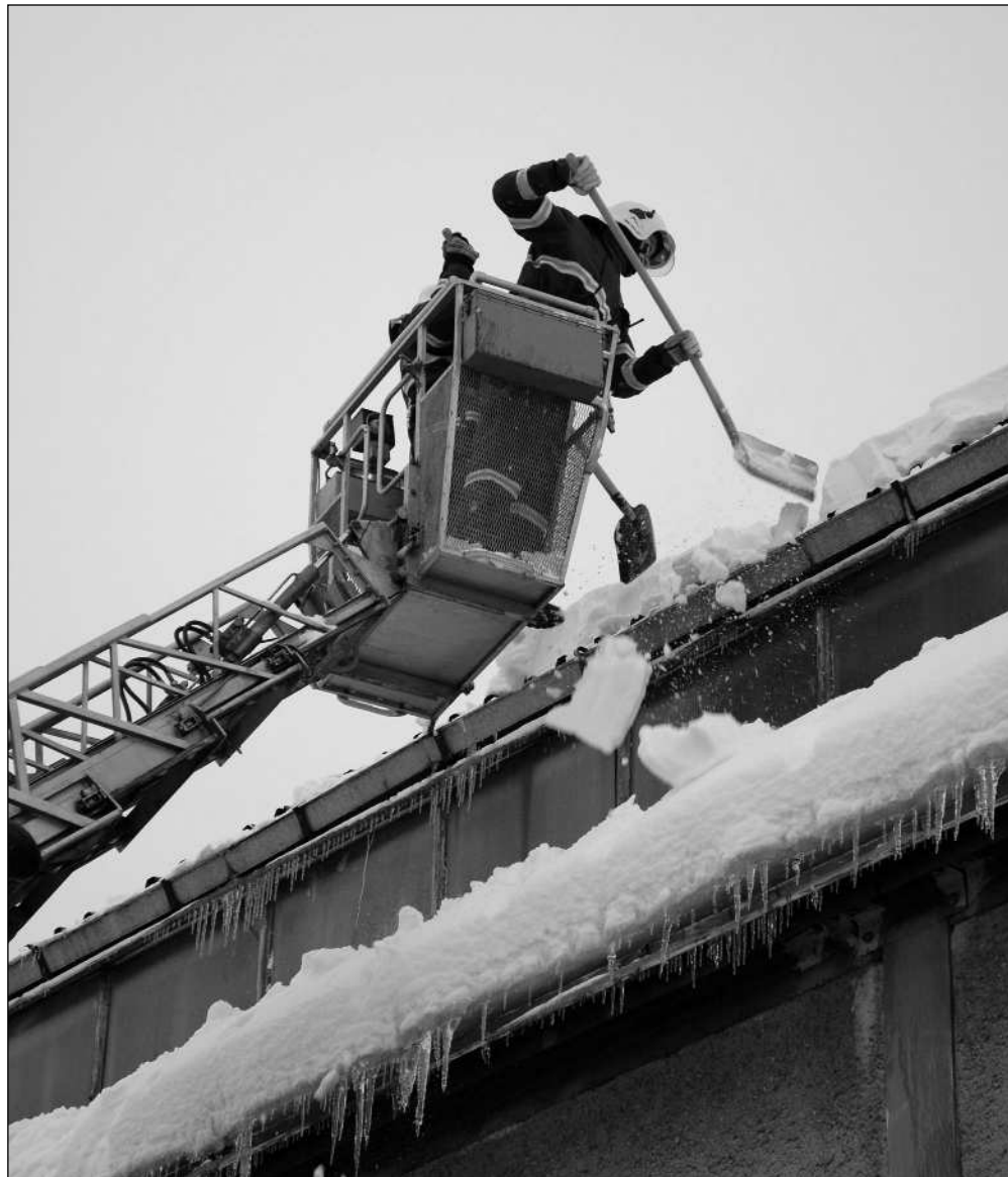
Na žádost starosty shazovali tatrováci hasiči sníh i ze střechy zimního stadionu. Měli tak odlehčit konstrukci zatíženou těžkou pokrývkou.
