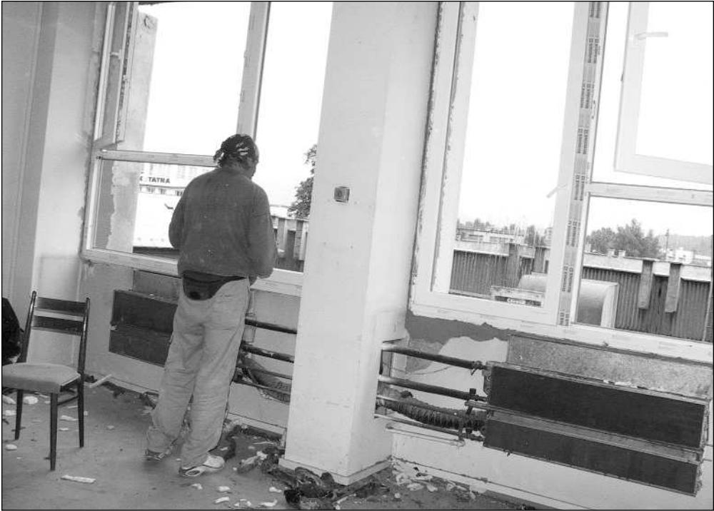
Litina z původních topných těles a hliníků z vyměněných oken v bývalé správní budově Tatro neskončí na skládce. Město tento odpad prodá firmě, která ho dál zpracuje.
