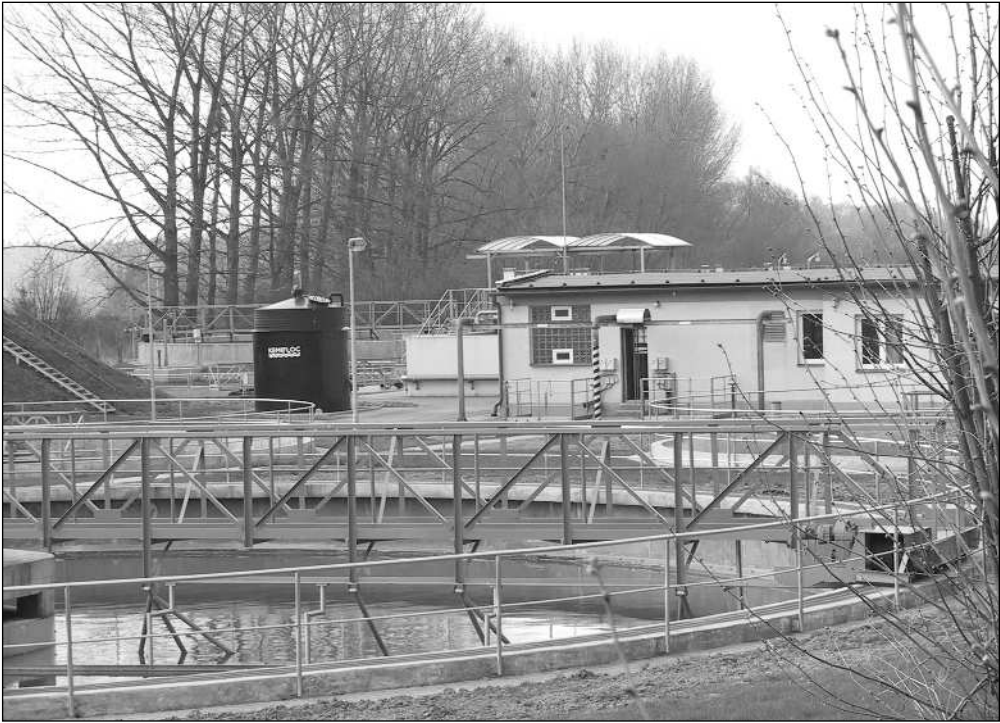
Kopřivnická čistírna odpadních vod. Právě zde by po vybudování nového kanalizačního řadu měly končit také splašky z Lubiny. FOTO: DAVID MACHÁČEK
