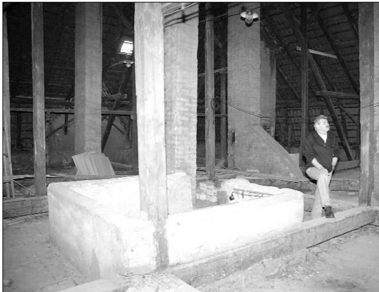
Prostorná puda Katolického domu v Kopřivnici se možná už letos po rekonstrukci dočká využití.
