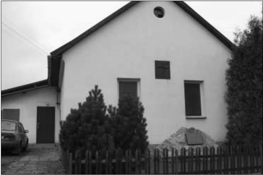
Prostory rodného domu nejslavnějšího ženklavského rodáka Kristiána Davida budou po ukončení rekonstrukce sloužit jako základna místnímu klubu důchodců.
