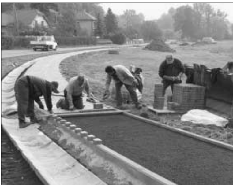
Lubinští budou mít možnost už brzy využívat chodník vedoucí od hasičárny až ke křižovatce u motorestu Pyramida.
