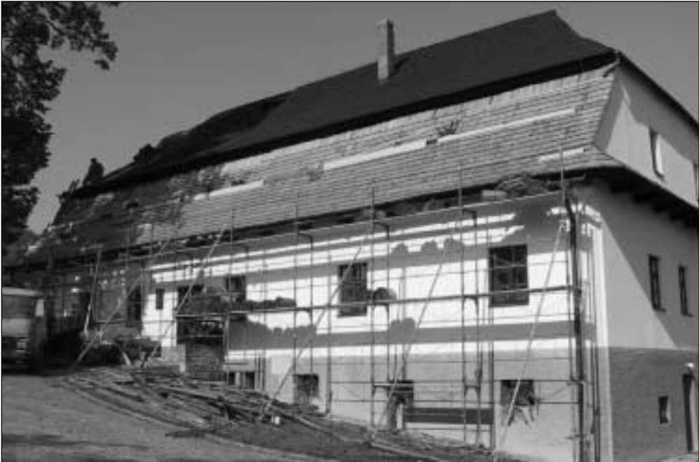
Oprava střechy na muzeu Fojtství byla nutná dříve, než se čekalo. Původní šindele byly z nekvalitního dřeva a byly již prohnílé.
