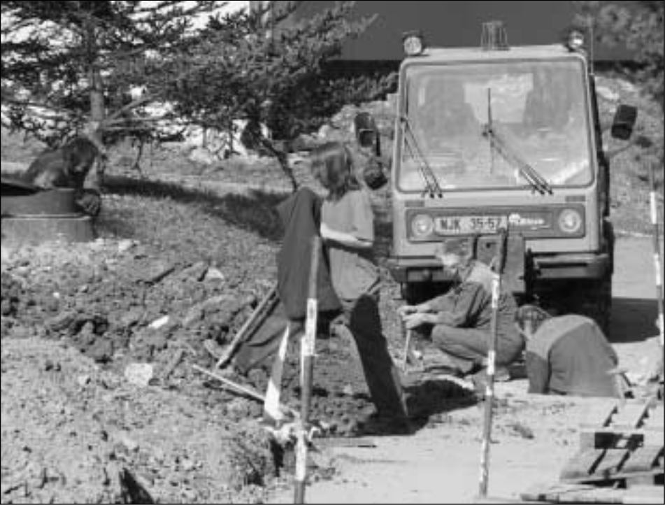
Nové svody vody, které mají zabránit podmáčení zprivatizovaných domů na takzvaných 'Hradčanech', v těchto dnech realizuje Slumeko.
