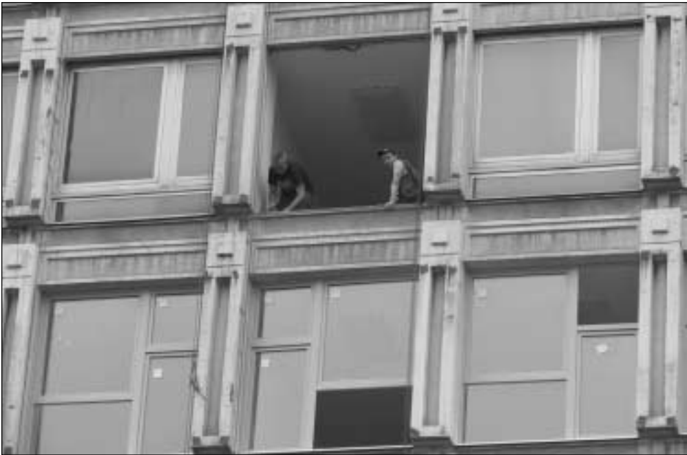
Operavy někdejší správní budovy Tatry, ze které se stane sídlo několika úřadů, začaly. Dělníci musí vyměnit bezmála 800 oken.
