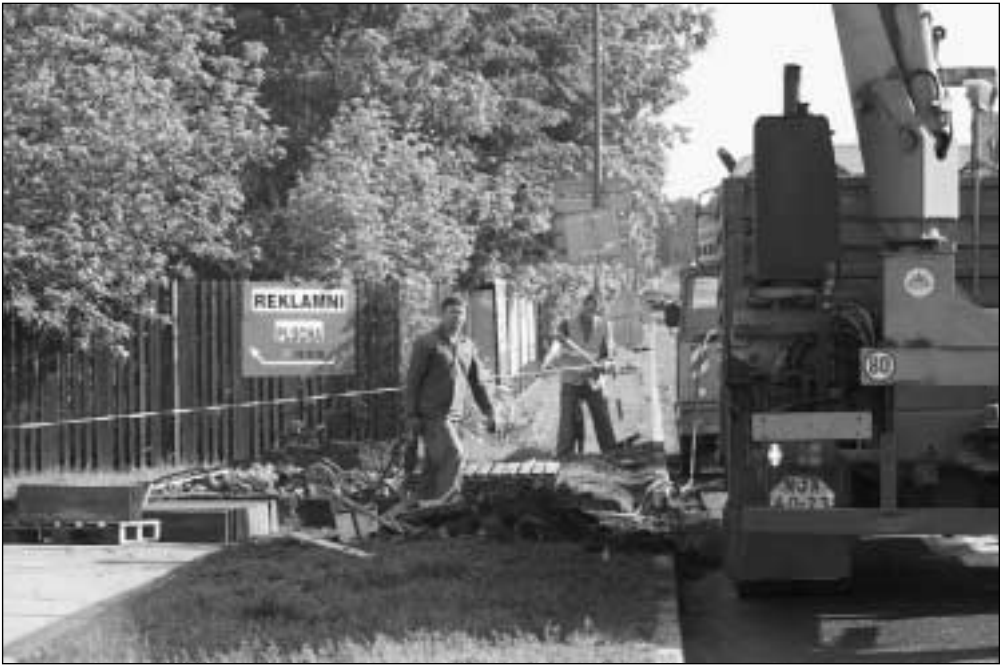
Úpravy přechodu přes frekventovanou silnici u házenkářského hřiště představují až nečekaně rozsáhlý stavební ruch
