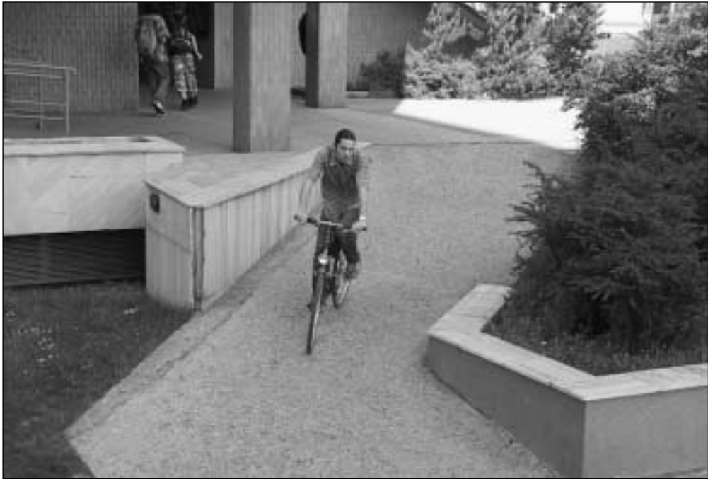
Na opravu nájezdu ke kulturnímu domu nejsou v rozpočtu peníze. Lidé na vozících nebo s kočárky se tak budou muset nadále potýkat s rozbitým povrchem.
