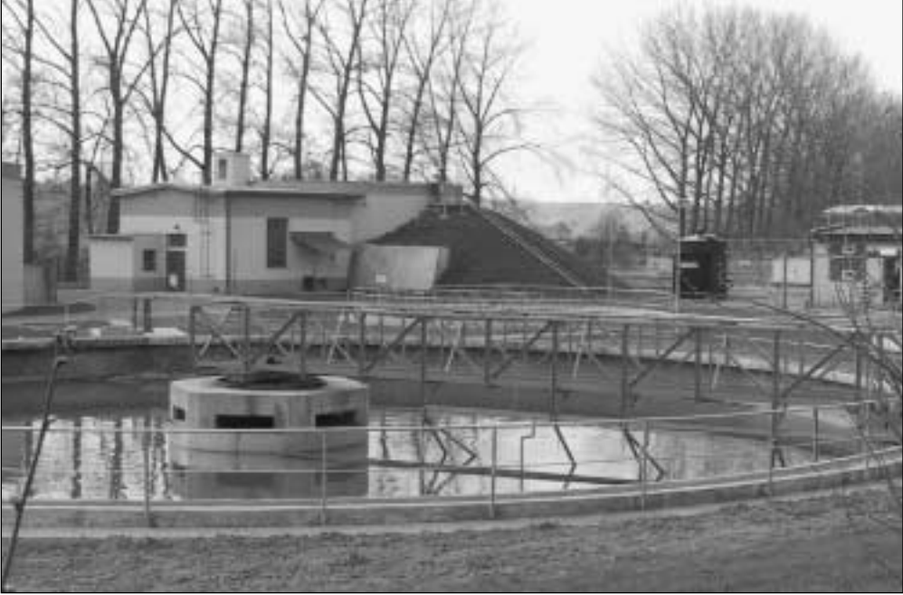
Nově rekonstruovaná část kopřivnické čističky odpadních vod byla do provozu uvedena vloni na podzim.
